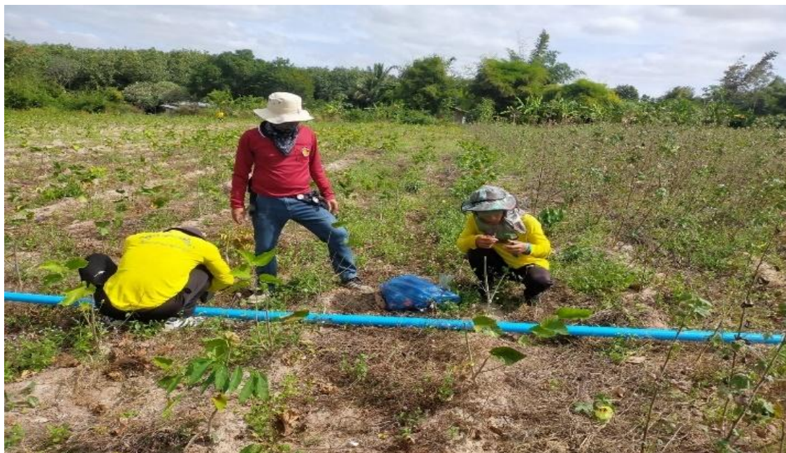
ภาพที่ 4.101 การติดตั้งระบบน้ำในที่ดินแปลงรวม
